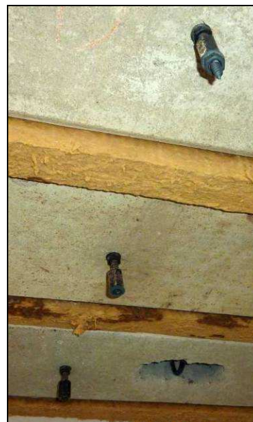
Pohled na KPO po zkoušce
